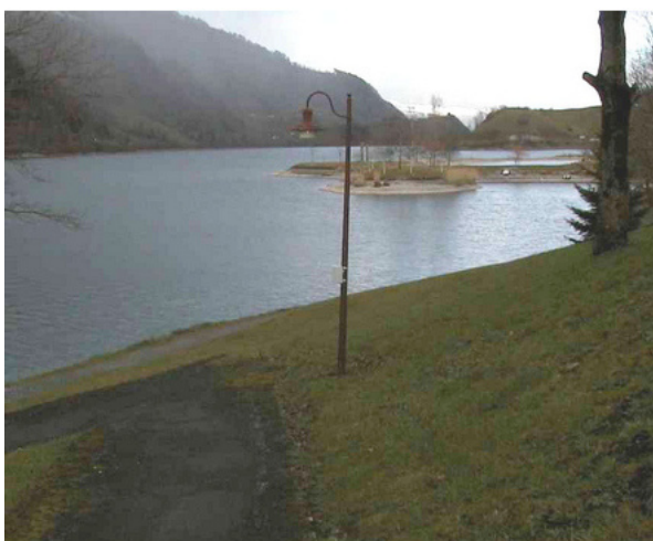
Sensor im AP-Aussengehäuse montiert und direkt gekoppelt mit Aussenbeleuchtung
